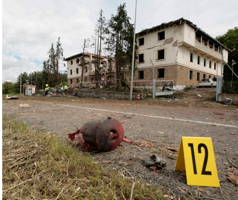
Estado de la casa cuartel de la Guardia Civil de Legutiano tras la explosión de un coche bomba de ETA en la que ha fallecido una persona y cuatro resultaron heridas de distinta consideración (14/05/2008). Adrián Ruiz de Hierro, EFE.
