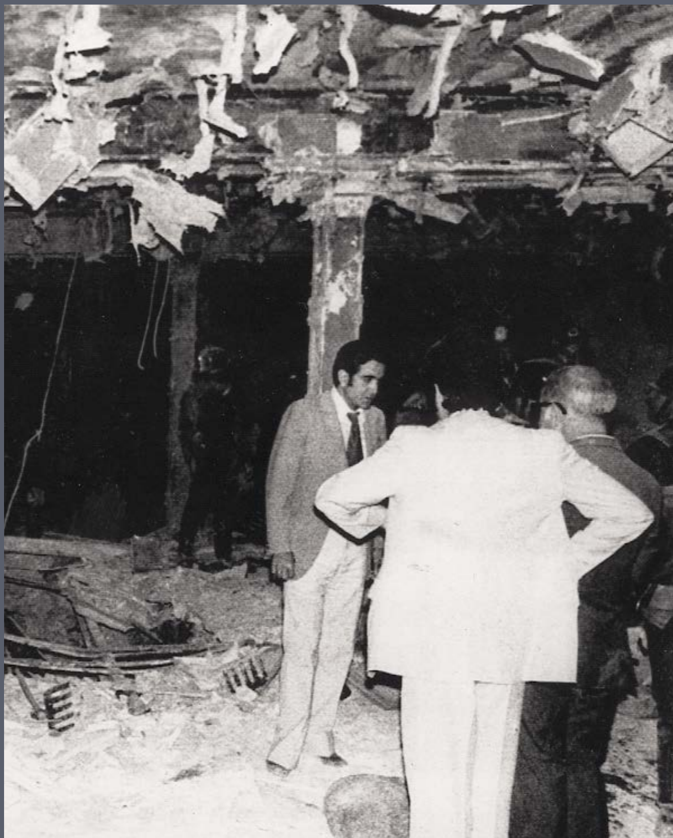
Fig. 6. Estado no que quedou o interior da cafetería Rolando tras a explosión dunha bomba de ETA. Madrid, setembro de 1974. Fotografía: AMB, Fondo de La Gaceta del Norte.
