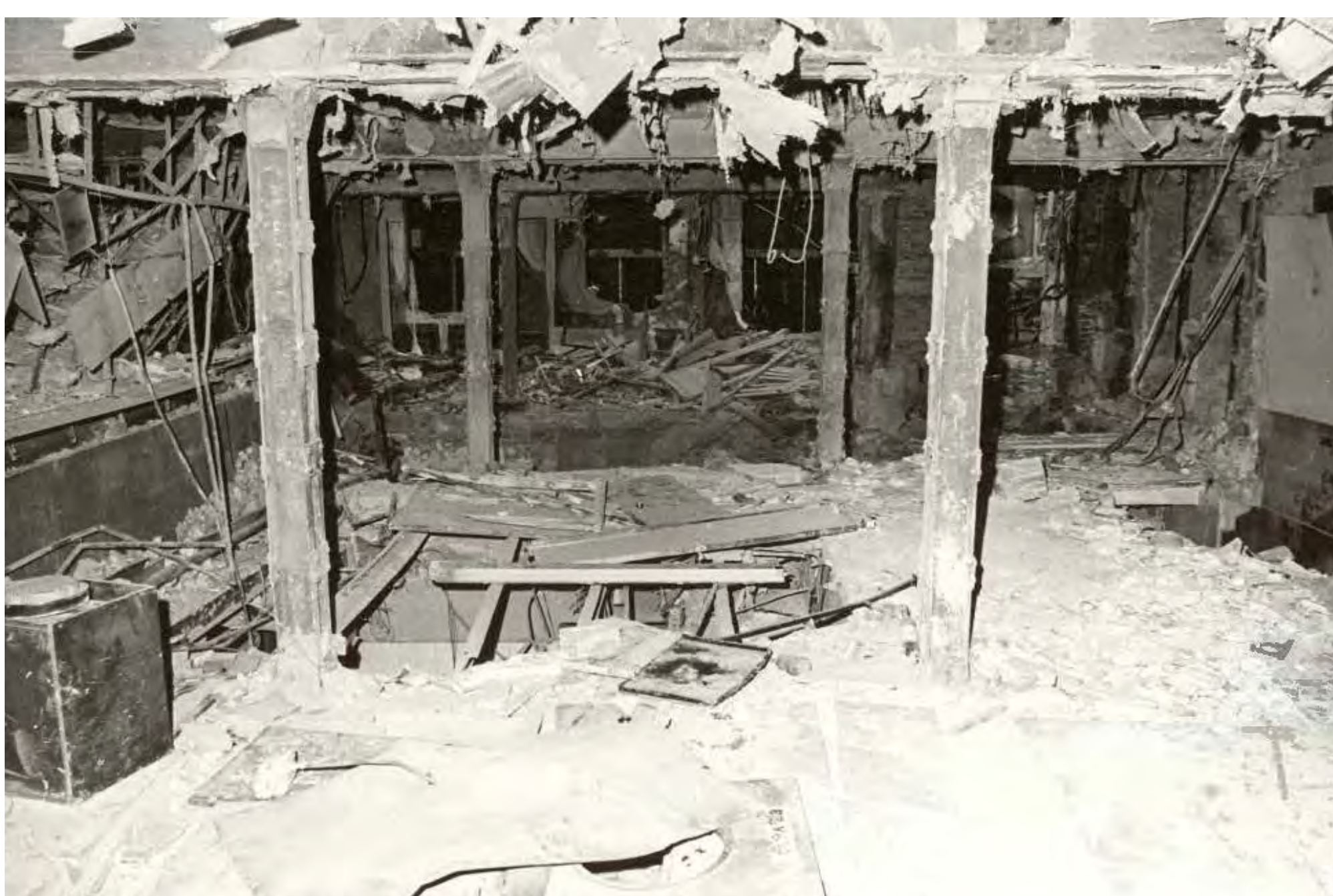
Interior de la cafetería Rolando tras el desescombros.
