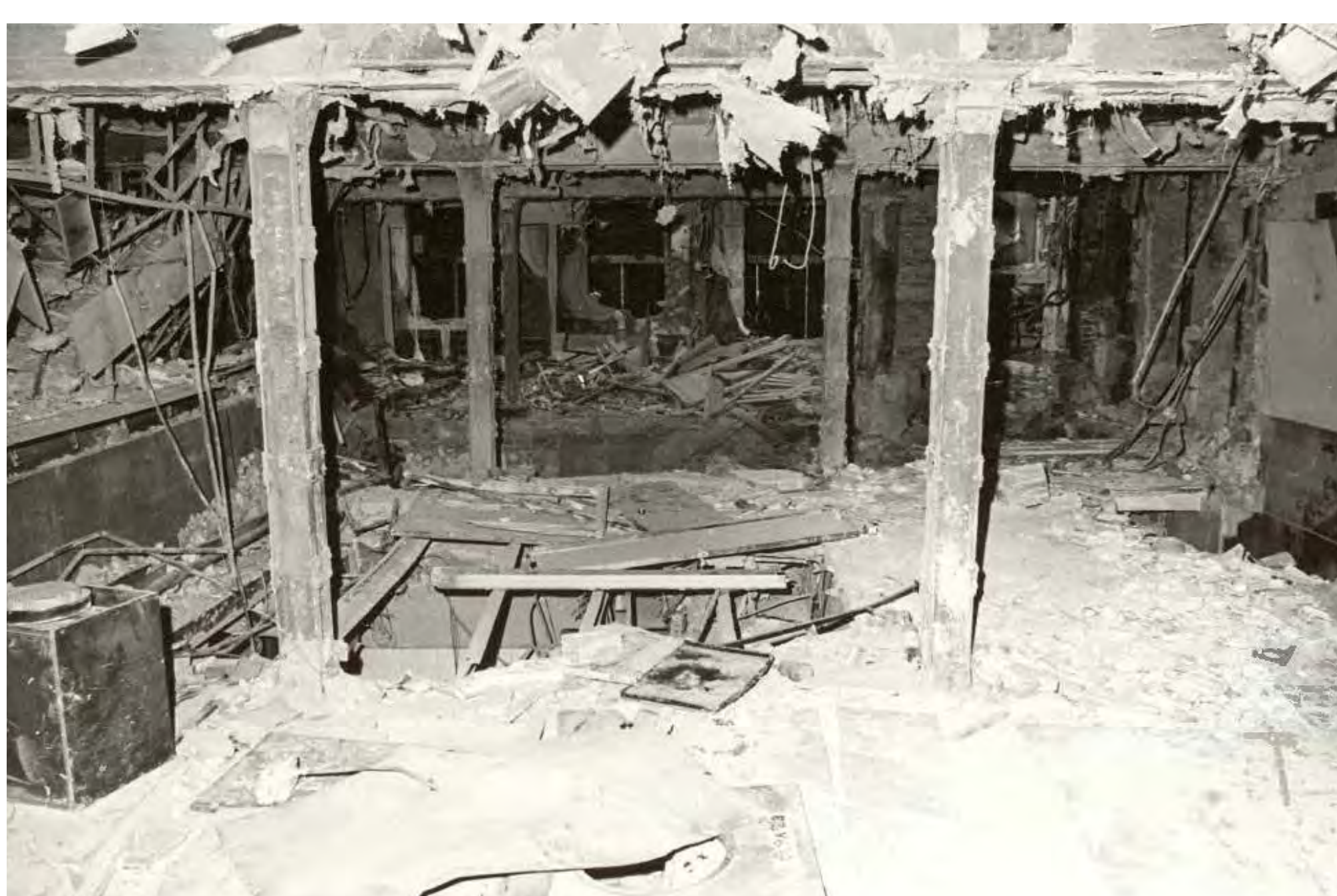
Interior de la cafetería Rolando tras el desescombro.
